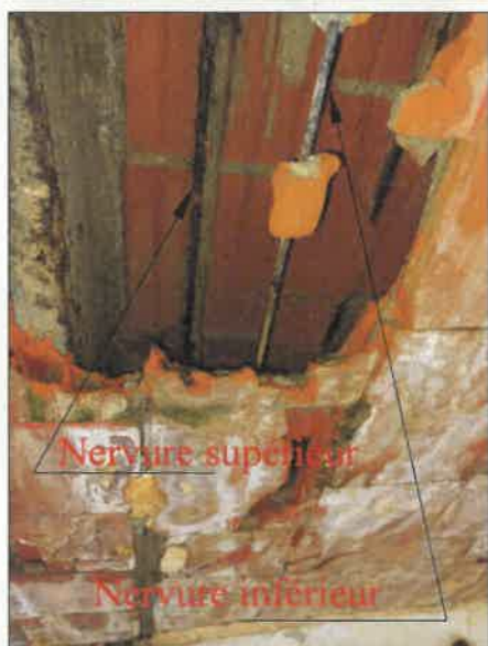
Corrosion de la nervure supérieur
